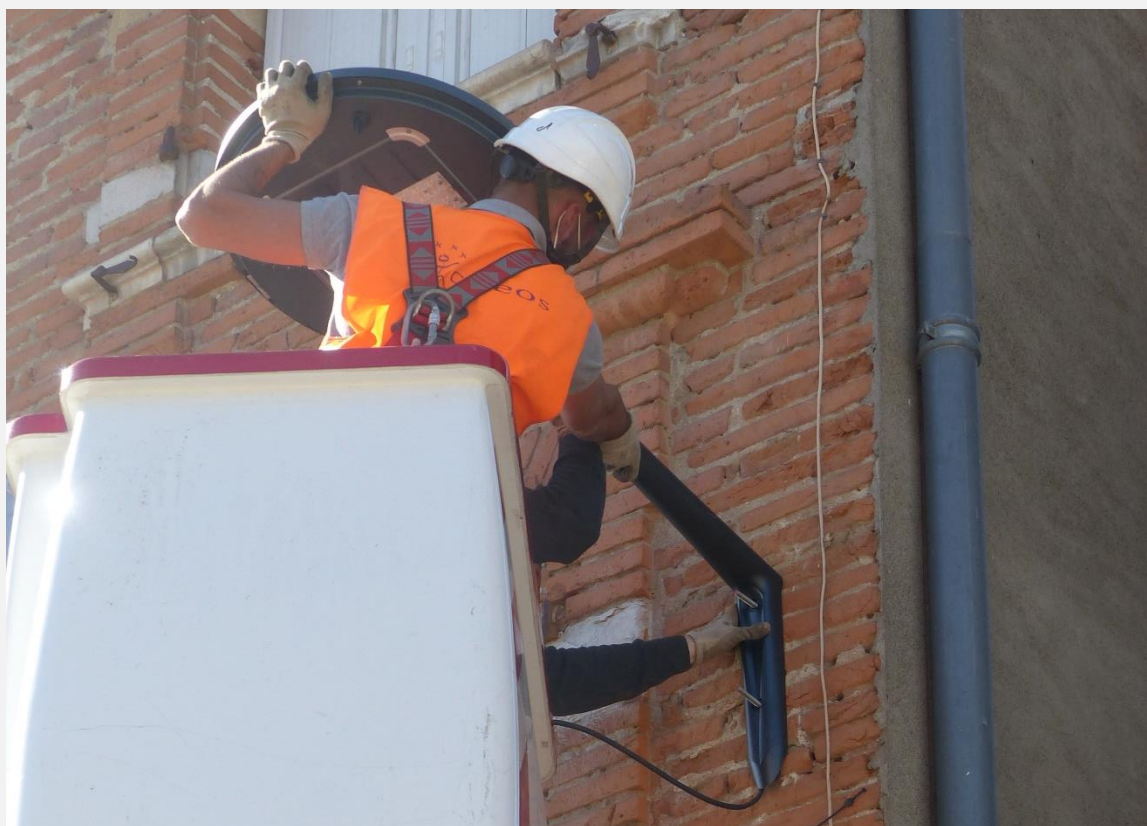
Les luminaires d'éclairage vétustes de l'avenue des Pyrénées à Muret sont rénovés et remplacés par des LED économes en énergie. Cette opération permettra à la Ville de réaliser 77% d'économies d'énergie.
