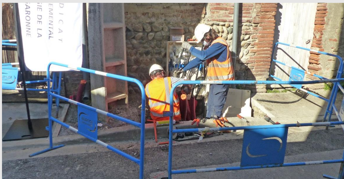
Chantier d'enfouissement des réseaux aériens d'électricité, d'éclairage public et de télécommunications à Noé.
